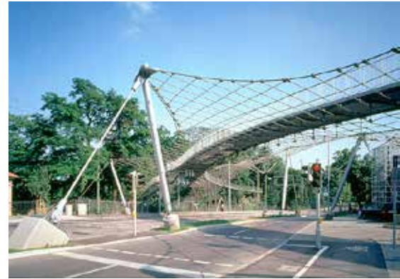
Eine vorgespannte Netzkonstruktion bildet die Basis für den 1993 errichteten Löwentorsteig in Stuttgart.
